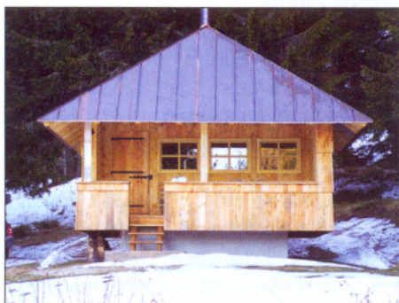
Gola pločevinasta kritina ima relativno visoko solarno reflektivnost (okrog 0,60), toda zelo majhno termično emisivnost (samo okrog 0,10).
