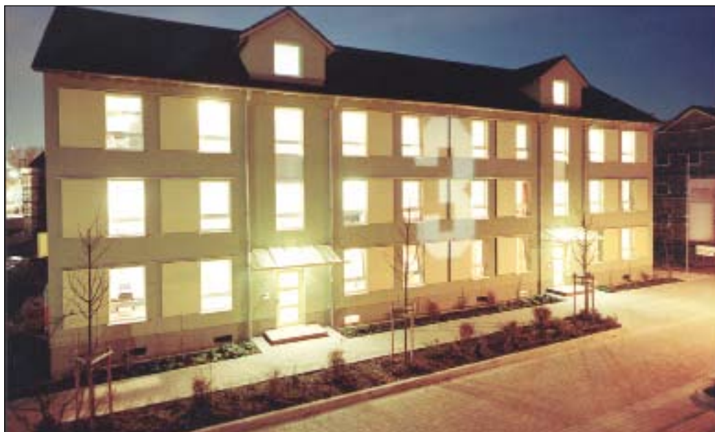
Sanacija večstanovanjskega objekta v nizkoenergetskem standardu: kontaktno izolacijska fasada s ploščami BASF Neopor® (ali Fragmat EPS Super), dobra toplotna kapaciteta je ohranjena v notranjih masivnih zidovih in masivnih medetažnih konstrukcijah.
