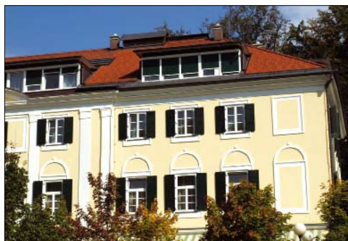
Energetska učinkovitost stavb je pri nas v povprečju še vedno slaba, zato je največji možni potencial varčevanja z energijo prav pri ogrevanju objektov.
