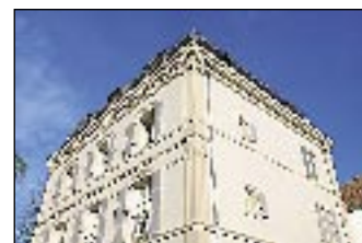
Uspešna sanacija starejšega objekta v Franciji ob upoštevanju prvotne estetike in oblike ter ohranjanju prvotne arhitekture.
